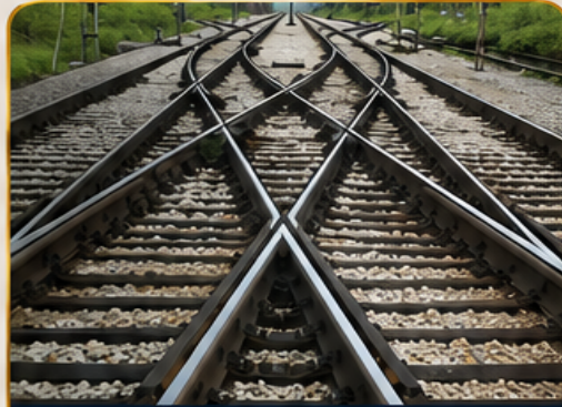
سكك حديدية RAILWAY TRACKS
